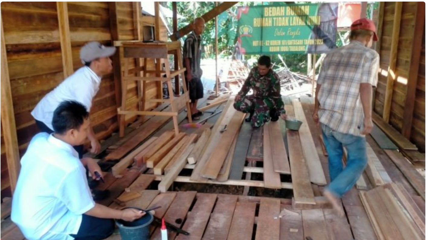
Kodim 1008/Tabalong Rehab Rumah Warga Tidak Layak Huni
